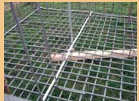
Vorbereiteter Fundamentkorb mit Fundamenterder, Bewehrungs- und Abzweigklemmen.
