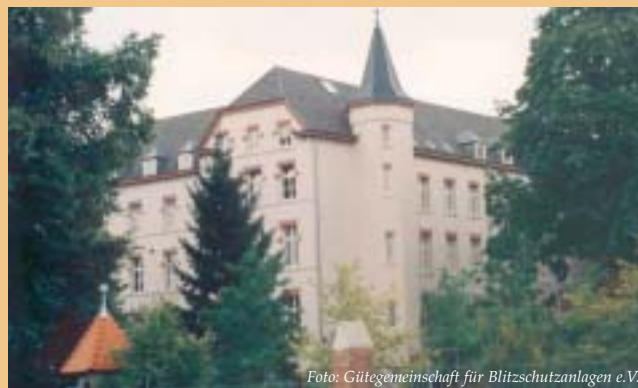
Foto: Gütegemeinschaft für Blitzschutzanlagen e.V.
